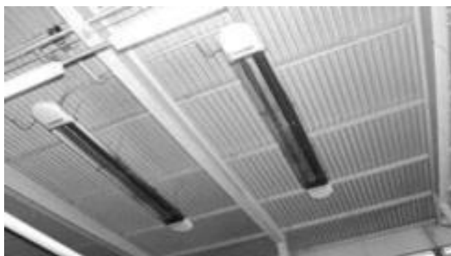
Рисунок 19 - Использование «темного» ИК-излучателя на свиноферме.
